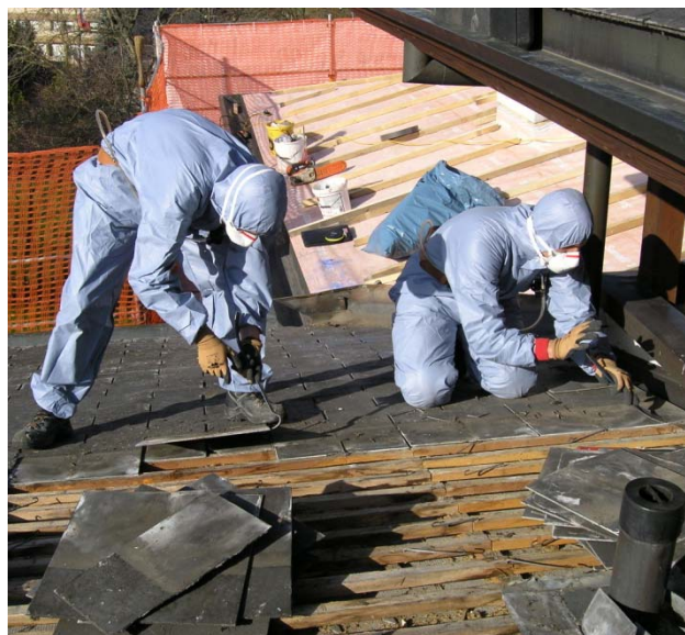
3 Pour éviter de mettre leur santé en danger, les travailleurs doivent effectuer le démontage sans destruction et porter un équipement de protection adapté.
